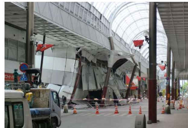
熊本地震の影響で半壊したアーケード
