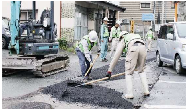
道路の応急復旧(熊本市西区、4/23)
